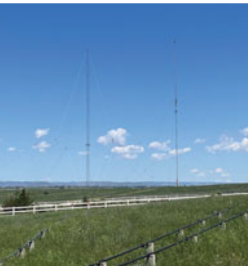
KW-Antennen des WWV-Senders
