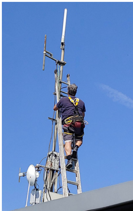
OE2EZM bei der Installation des Dummy Load
