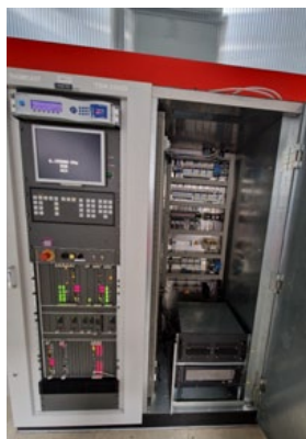
oben: die interessierten Teilnehmer im Kontrollraum unten: 100KW-Sender und die Endstufe des 300KW-Senders
