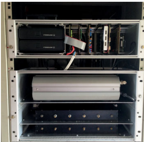
2 m (ohne Filter), 70 cm Relais (mit Filter), Steuerung
