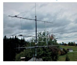
Sonntagvormittag war die Tropo besonders gut ausgeprägt, einige Stationen aus OE konnten sogar in SSB und auf dem 70 cm-Band DX-Verbindungen herstellen. Ich benutze für 2 m DX einen IC-7100 mit einer 300W PA und eine 13 Element Crushraft Yagi-Antenne.
