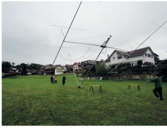
Hochziehen der 2x8 el 50 MHz Yagis mit Hilfsmast
